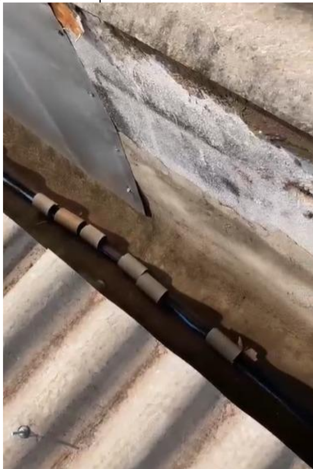
Figura 22. Falta de placas de zinco em determinados locais.
