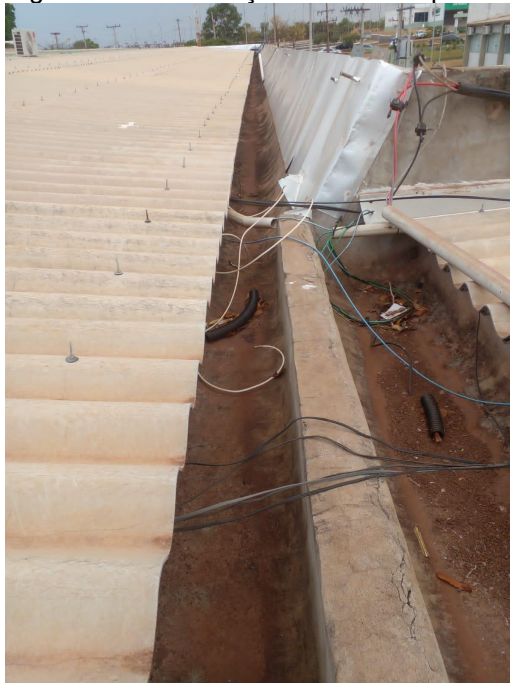
Figura 25. Deterioração do sistema pluvial.
