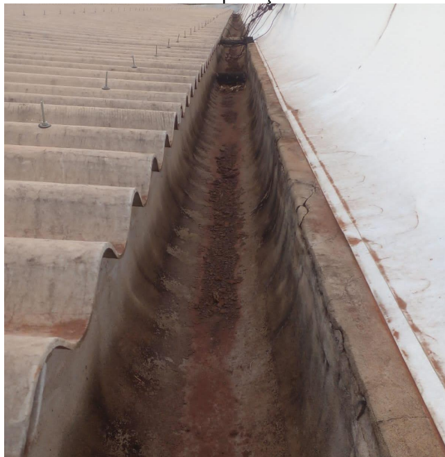
Figura 3. Calhas em concreto com fissuração e deslocamento pela exposição ao sol e falta de proteção.
