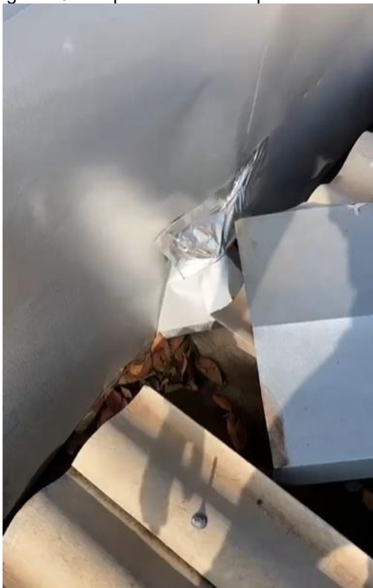
Figura 18. Desprendimento nas placas de zinco.
