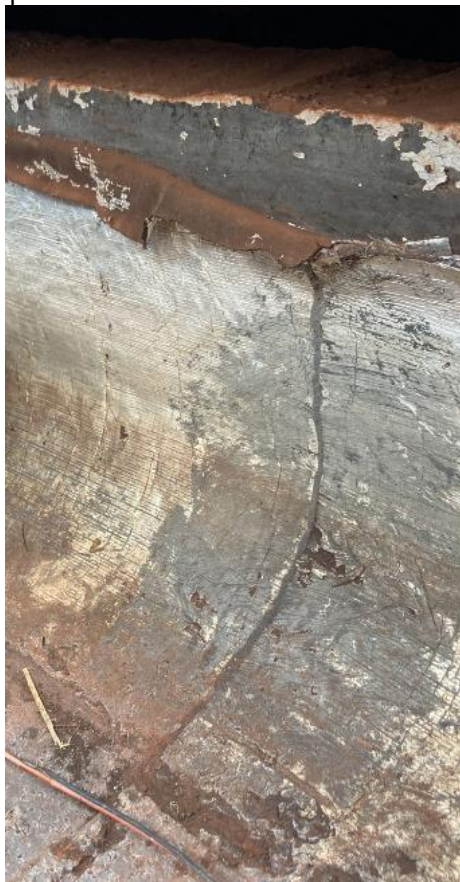
Figura 14. Desprendimento da manta asfáltica existente nas calhas.
