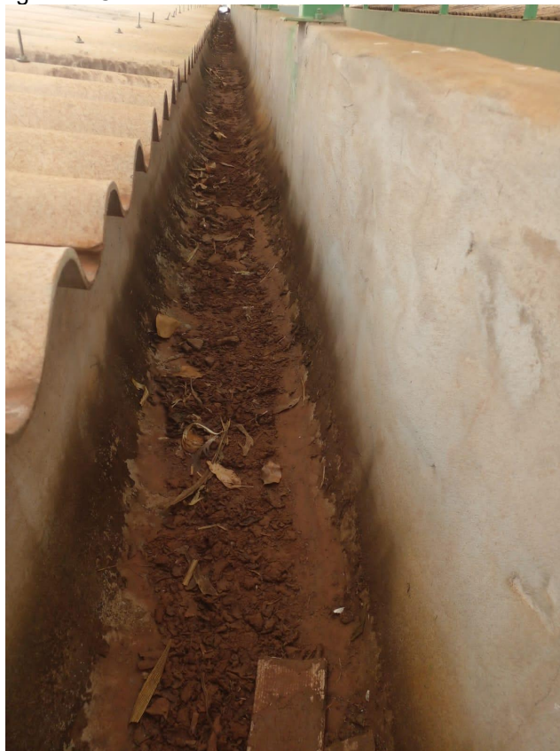
Figura 4. Calhas em concreto com acúmulo de detritos.
