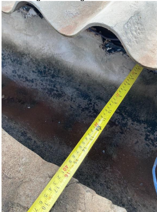
Figura 23. Largura de calha.
