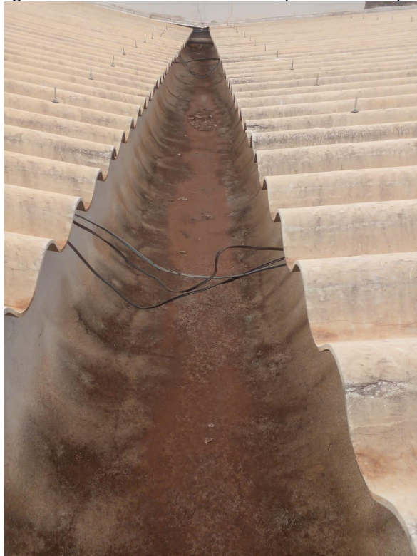
Figura 8. Calhas com falhas de impermeabilização.
