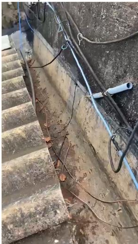
Figura 15. Fiação elétrica em desconformidade.
