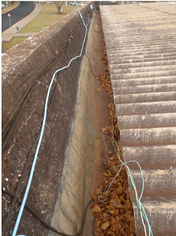
Figura 7. Calhas em concreto com ascensão de umidade.
