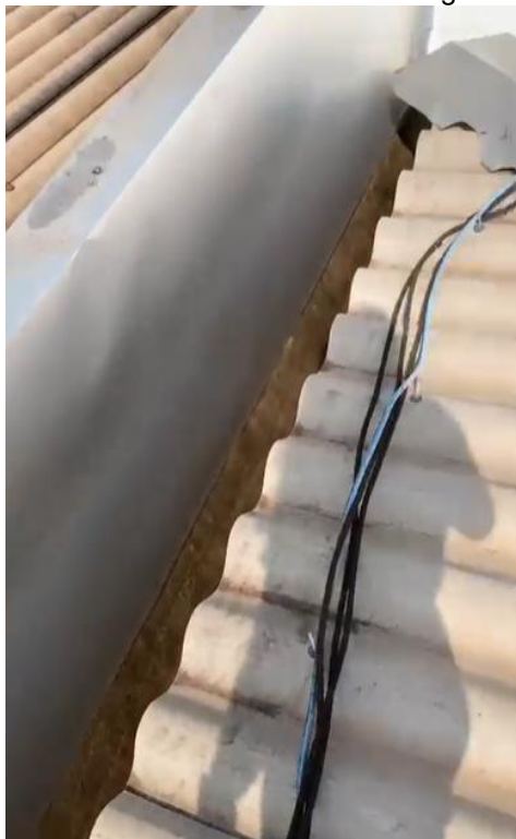
Figura 20. Trecho de calha em conformidade e boa integridade física dos materiais.
