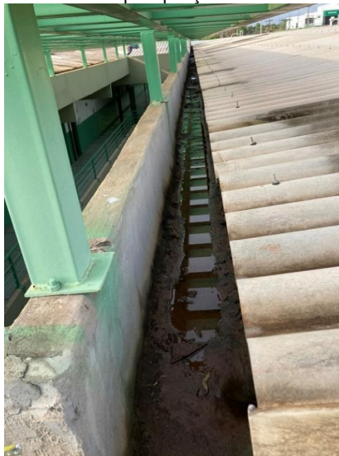
Figura 11. Acúmulo de água e lama em determinados trechos das calhas, após precipitação.
