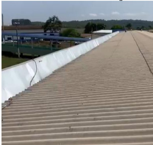
Figura 21. Trecho de calha em conformidade e boa integridade física dos materiais.
