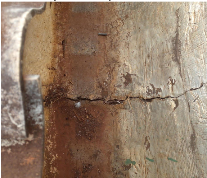
Figura 5. Fissuração das calhas.
