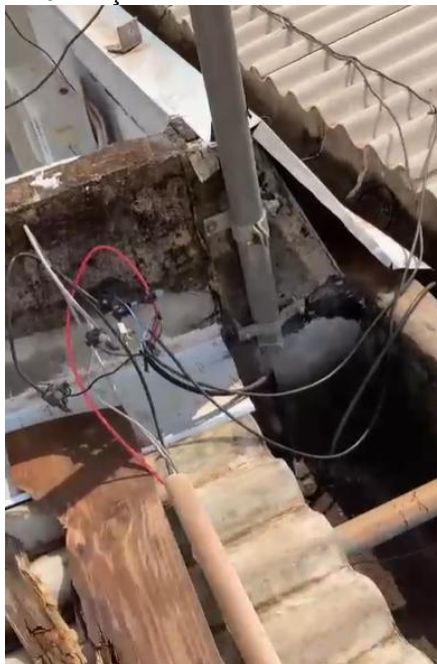
Figura 16. Fiação elétrica em desconformidade.
