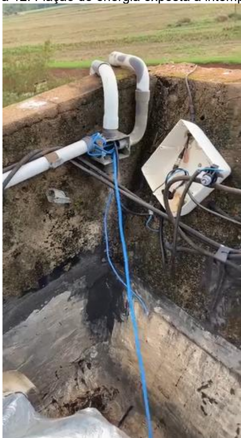
Figura 12. Fiação de energia exposta a intempéries.
