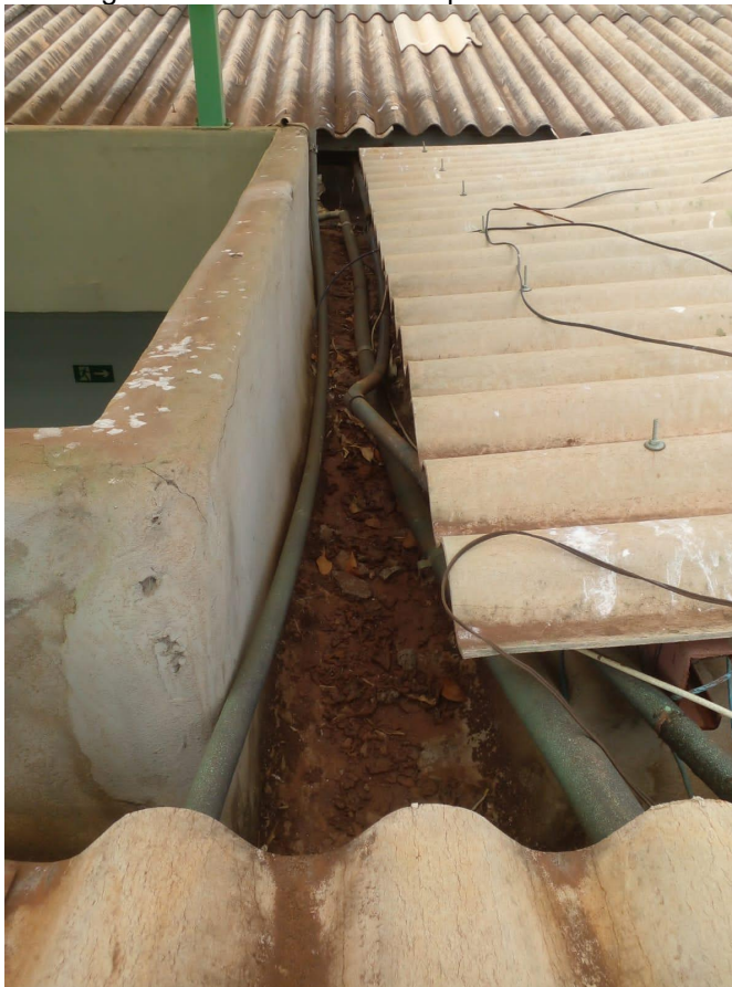
Figura 6. Calhas a serem impermeabilizadas.
