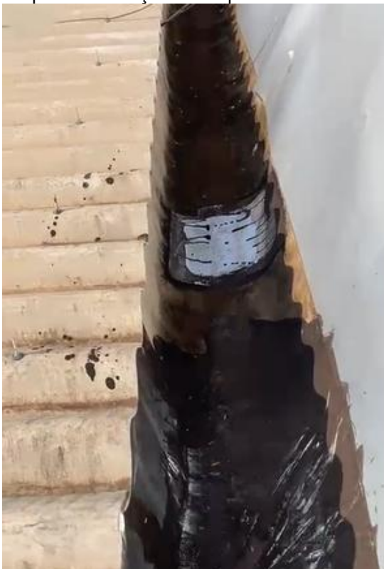
Figura 10. Impermeabilização inadequada em trechos das calhas.
